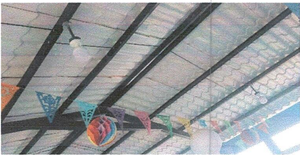
Foto 3: Sustitución de focos ahorradores
