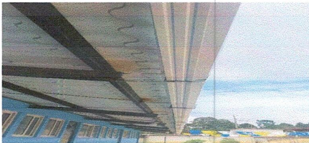
Foto 5: Sustitución de canales de PVC por metal
